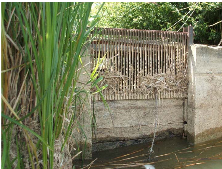
Vue sur la grille en amont de la canalisation
