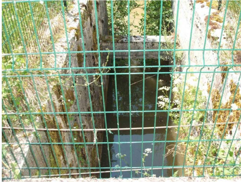
Vue sur la canalisation depuis la digue/barrage
