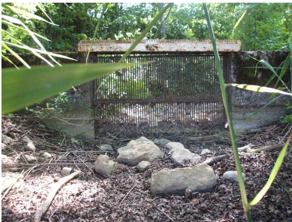
Vue sur la grille d'un des déversoirs latéraux
